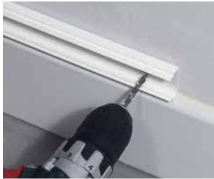
2 Duvarın yapısına göre, vida veya çivi kullanarak kablo kanalını duvara sabitleyin.
