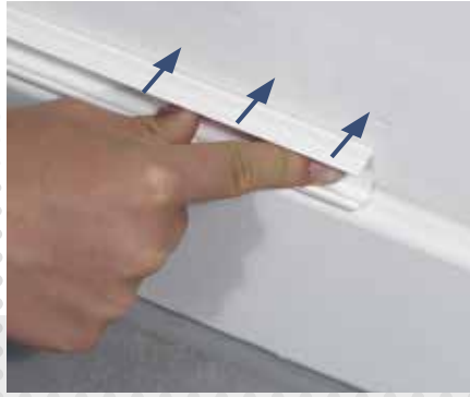
2 Kablo kanalını istediğiniz konuma getirin ve duvara doğru kuvvetlice bastırın. Kalın yapışkan bant duvardaki pürüzleri doldurarak güçlü yapışma sağlar.
