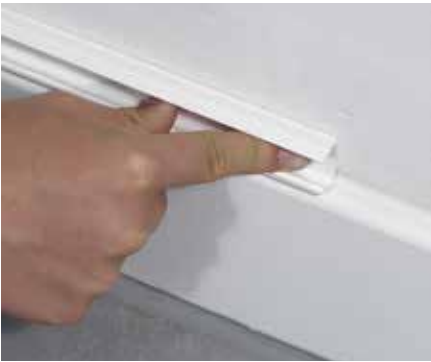
1 Kablo kanalını duvar üzerinde istediğiniz konuma getirin.
